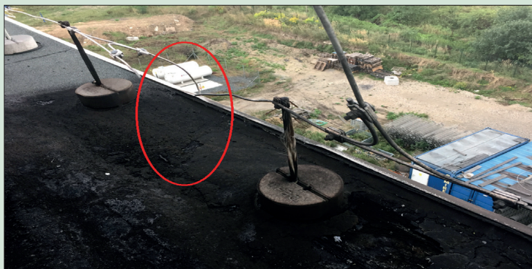
Obr. 1. Průřez bleskem izolovaného okružního vedení délky pouze 0,5 m
